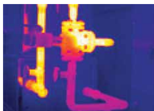
Проверка температуры подающего и обратного контура системы отопления
