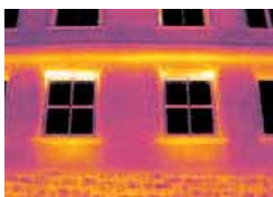
Демонстрация тепловых потерь при неправильной изоляции радиаторных ниш
