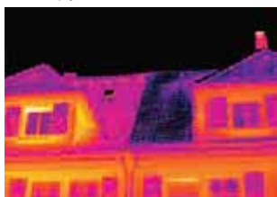
Проверка теплоизоляции в области крыш и слуховых окон
